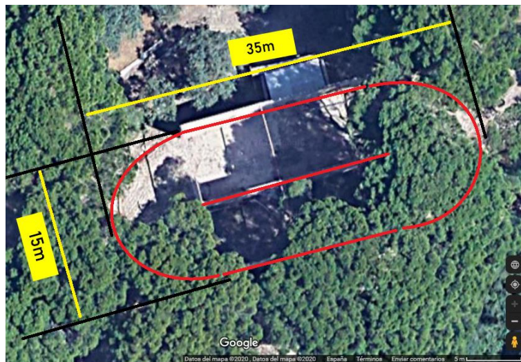
Figura 2. Voladero visto desde arriba. Líneas rojas: planta del voladero; líneas amarillas: medidas del voladero (ancho y largo). Fuente: Google Maps
