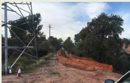
Obras de soterramiento de uno de los tendidos eléctricos que cruza el Parque Natural de la sierra de Collserola (Barcelona) (fotos: Joan Capdevilla).
