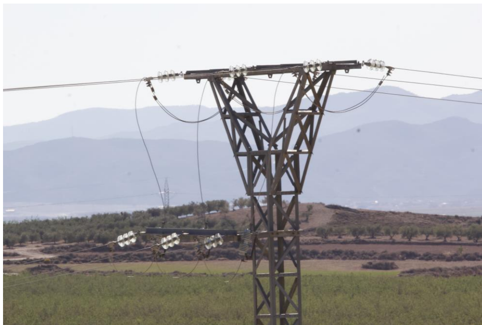
Imagen 50. Fotografías de los apoyos más cercanos a la balsa
