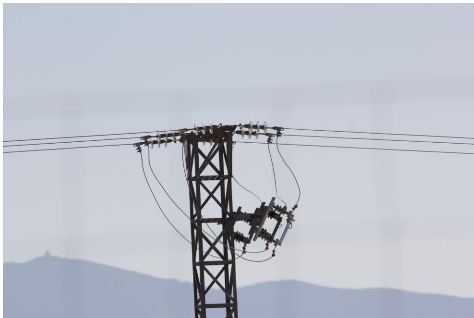
Imagen 49. Fotografías de los apoyos más cercanos a la balsa
