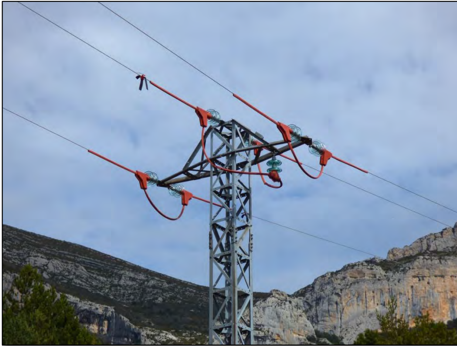
Fig. 3: Como medida preparatoria se adecuaron las dos derivaciones de propiedad particular próximas al lugar de liberación. Se ampliaron las distancias accesibles de seguridad y se protegieron con materiales preformados todos los puentes y elementos en tensión que podían suponer algún riesgo para las aves.
