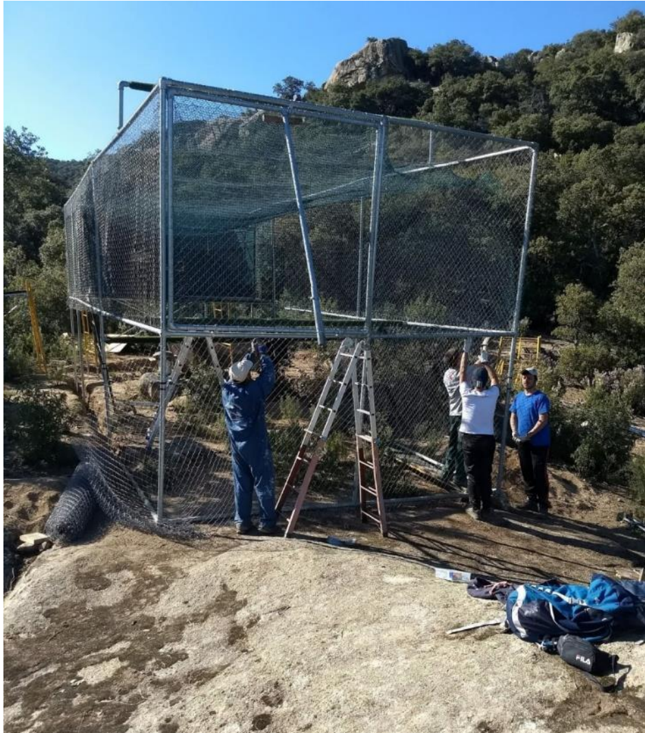
Ilustración 8. Construcción de la "Jaula-Hacking".
