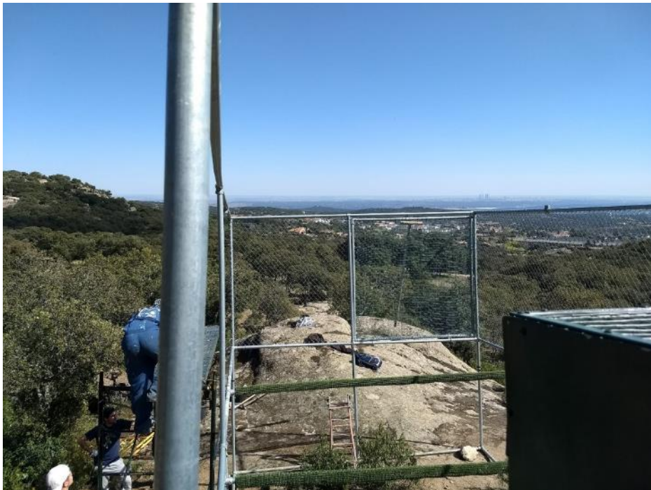
Ilustración 7. Construcción de la "Jaula-hacking".
