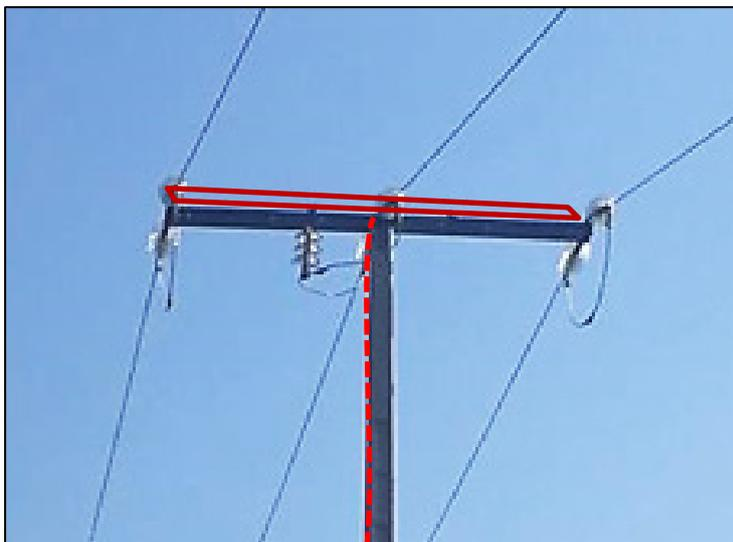
El circuito debe cubrir únicamente la cima de cruceta plana. Dependiendo de la anchura, precisará de doble circuito de ida y vuelta.
