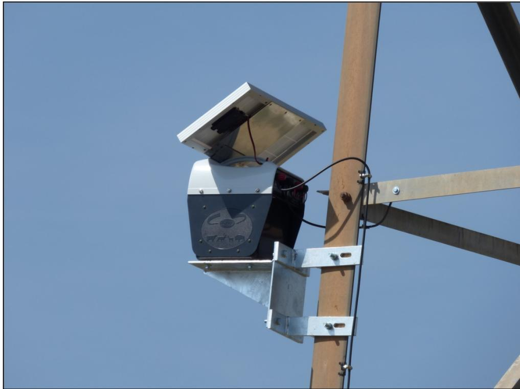
La unidad generadora compuesta por batería y placa solar se instalaría en el fuste (poste o torreta de celosía) de forma que no sea accesible al público e iría convenientemente señalizada. El circuito se cerraría (realizando el "disparo") por contacto de las aves entre el cable (fase) y el armado o la cima del fuste (tierra).
