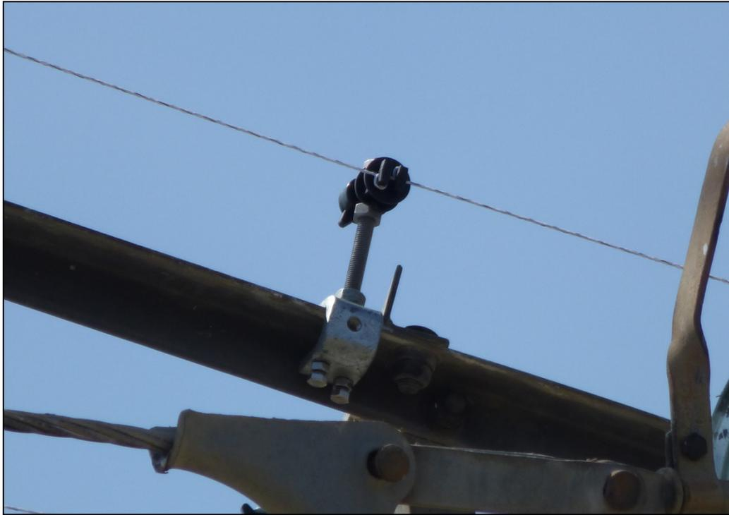
**Fig. 63:** Vista general del circuito del pastor eléctrico instalado a lo largo de los perfiles metálicos de uno de los semi-travesaños a proteger. (Foto©: C.Fdez.).
