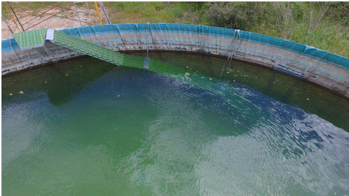
Foto provisional de rampa desmuntable de PVC amb fusible. Manca la doble rampa.
