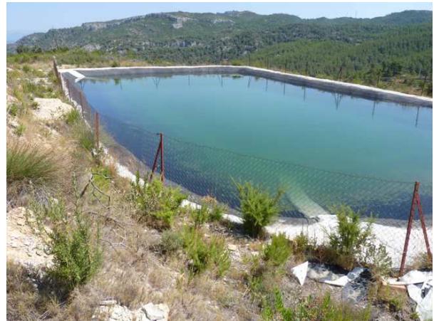
Rampa de formigó dissenyada pel Dep. d'Interior, ideal pels helicòpters i adequada per a tota la fauna.
