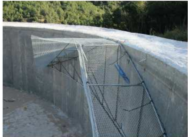
Instal·lació de la malla electrosoldada mitjançant brides
