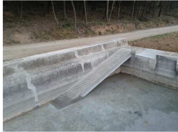
Rampa amb xapa perforada (esquerra) i d'obra (dreta), aquesta amb risc d'enganxar el bambi.
