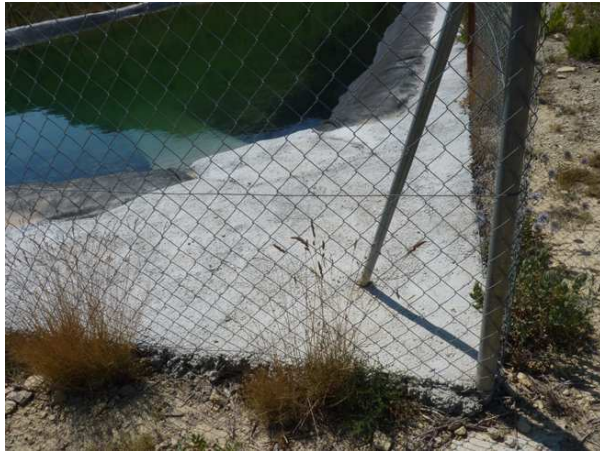
Rampa de formigó dissenyada pel Dep. d'Interior, ideal pels helicòpters i adequada per a tota la fauna.
