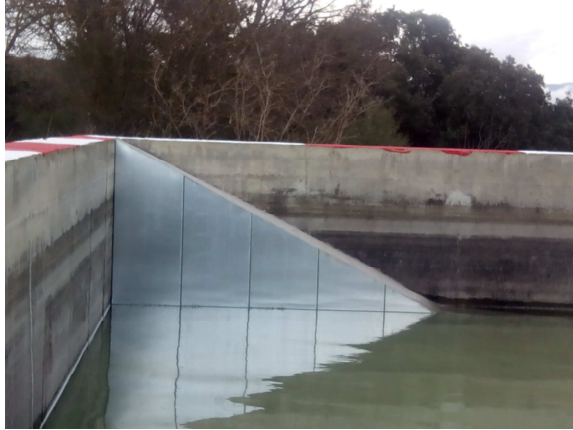
Rampa amb xapa perforada (esquerra) i d'obra (dreta), aquesta amb risc d'enganxar el bambi.
