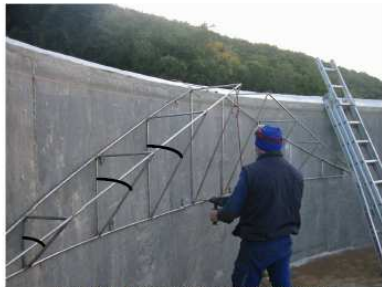
Nota: L'angle del despleg de l'estructura és d'uns 26 graus
