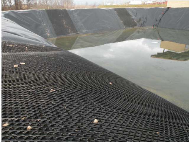
Geomembrana impermeable amb bandes de malla adossada Numagrid 1.8mm.
