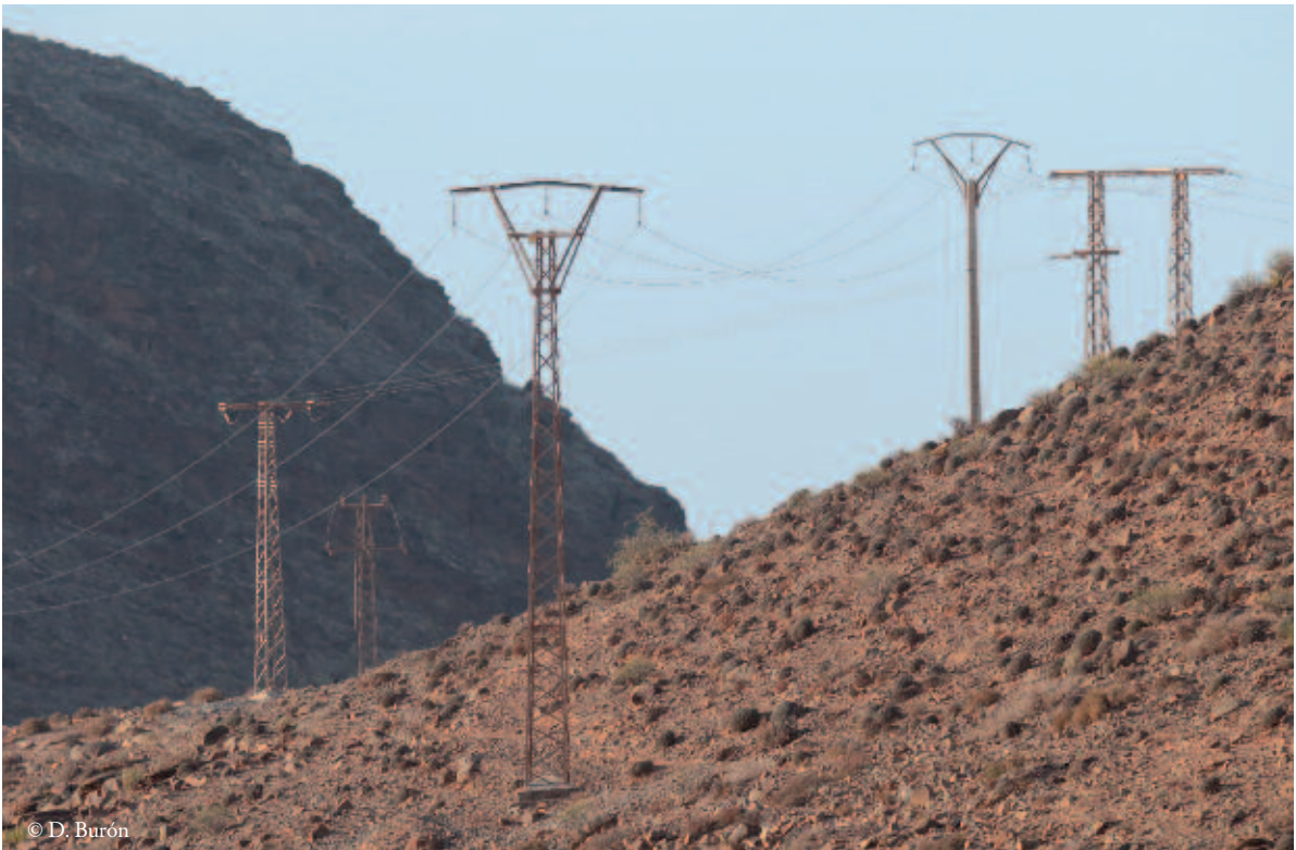
Figura 26. Conjunto de apoyos en la Línea A representativos de la mayor parte de tipos de apoyo localizados en este estudio, siendo los que aparecen en la imagen los de mayores tasas de mortalidad. Figure 26. Ensemble de pylônes de la Ligne A, représentatifs de la majorité des types de pylônes observés lors de cette étude ; cette photo illustre les types de pylônes générant les taux de mortalité les plus élevés.
