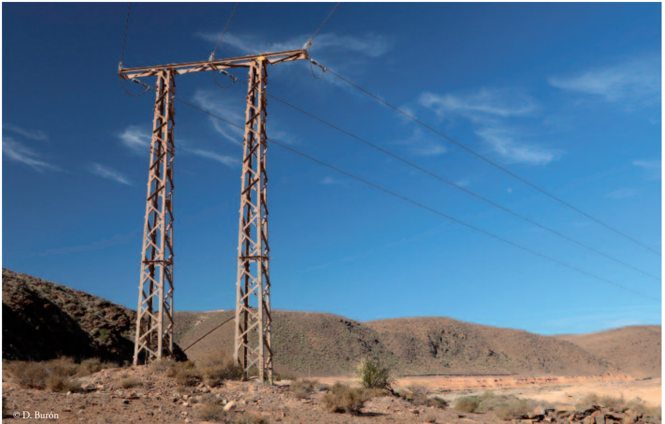
Figura 34. Apoyo tipo P-10, con pórtico (A-068). Figure 34. Pylône de type P-10 avec portique (A-068).
