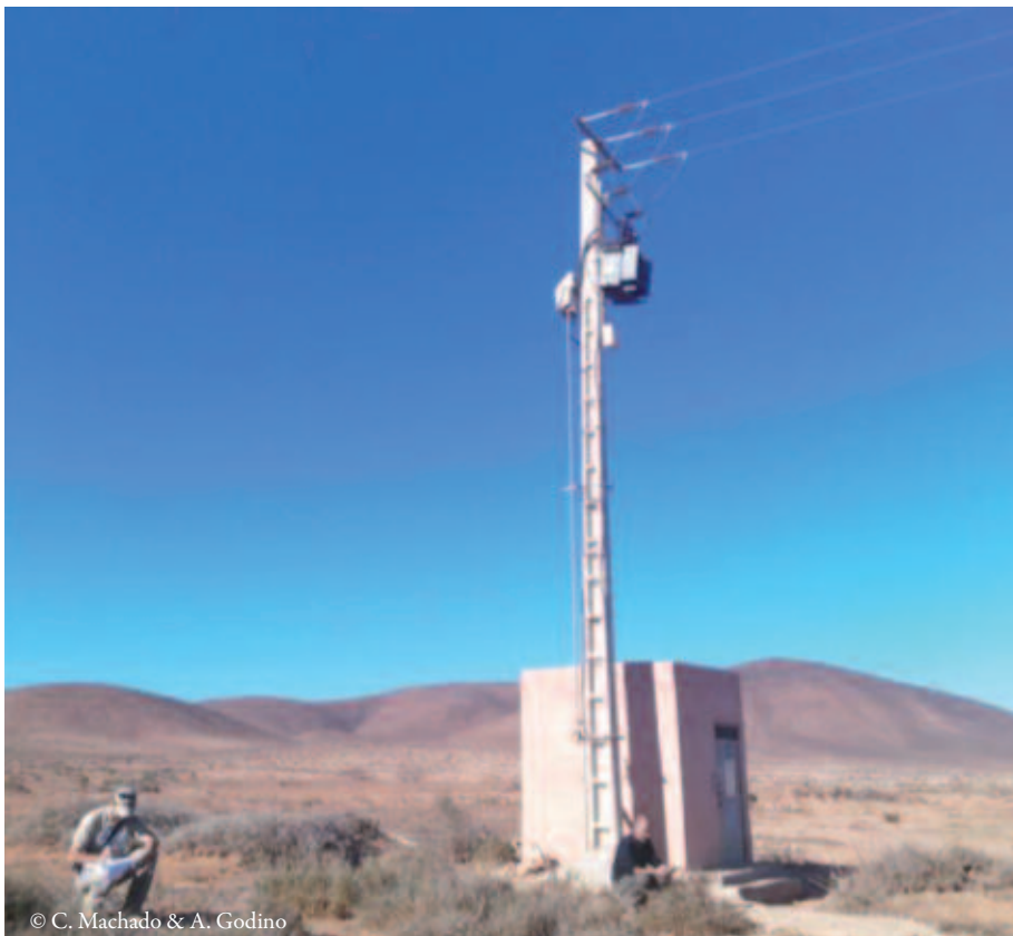
Figura 35. Apoyo tipo P-15, con seccionador tripolar en vástago (B2-006), y en este caso fin de línea con transformador, donde se encontraron dos halcones borniés ( Falco biarmicus ).
