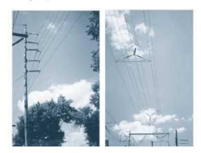
Figura 9. Configuraciones de fase partida vertical (izquierda) y hexagonal (derecha) para 115 kV.
