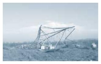
Desmantelamiento de un apoyo
