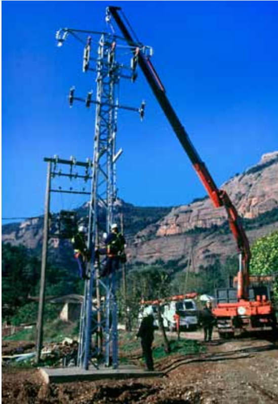
Fotografía 39. Tareas de corrección de un apoyo con seccionador, consistente en la sustitución de un transformador antiguo peligroso (abajo izquierda en segundo plano) por un nuevo modelo de diseño seguro (delante primer plano). Autor: EBC-UB.
