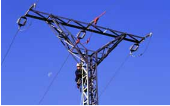
Fotografía 34. Tareas de corrección de un apoyo en bóveda, consistente en el aislamiento del puente flojo central con materiales de alta durabilidad. Fotos: Albert Tintó.
