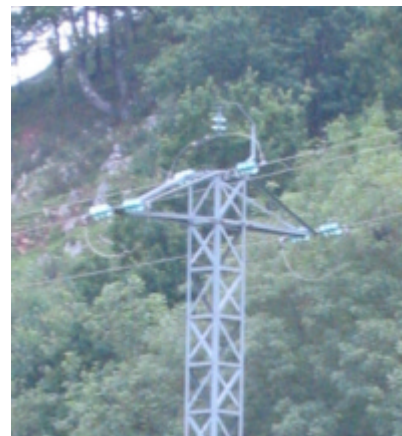
19D MONTAJE 1 AMARRE INFERIOR Metálico+farolillo
