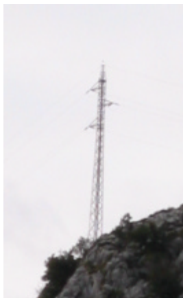
1K TRESBOLILLO Metálico+amarre+trnasformador
