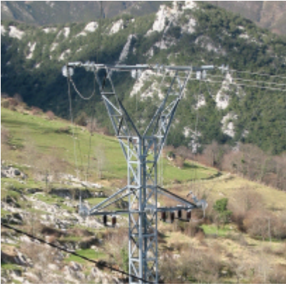
42A MONTAJE 0 AMARRE INFERIOR Metálico+derivación
