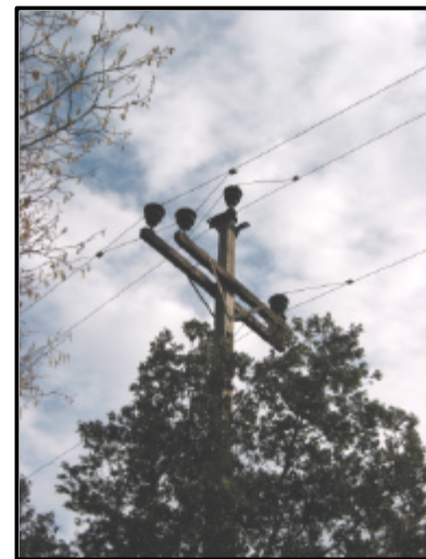
Montaje 1. Alineación rígido. Riesgo variable
