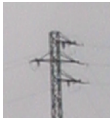
1T TRESBOLILLO Metálico+amarre+seccionador+derivación
