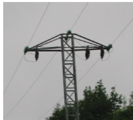
46D MONTAJE 1 AMARRE INFERIOR Metálico+seccionador
