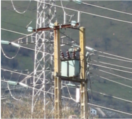
40 MONTAJE 0 AMARRE SUPERIOR Hormigón +transformador
