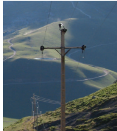
17B MONTAJE 1 AMARRE SUPERIOR Hormigón
