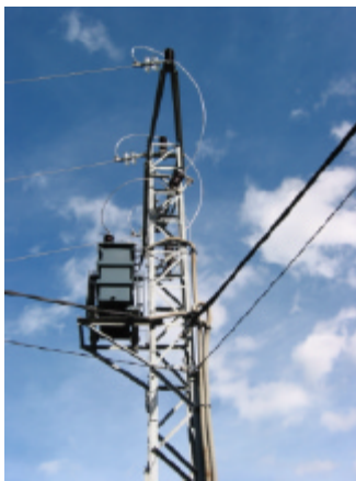
39A MONTAJE 0 AMARRE INFERIOR Metálico+transformador
