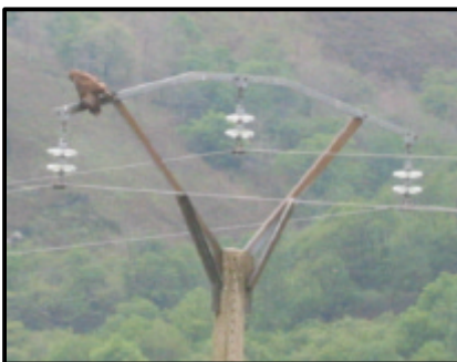
Busardo ratonero ( Buteo buteo ) posado en un apoyo tipo bóveda alineación. Riesgo despreciable
