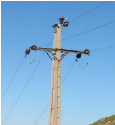
17A MONTAJE 1 AMARRE SUPERIOR Hormigón
