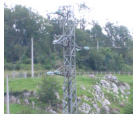
63 TRESBOLILLO Metálico+amarre+seccionador+derivación
