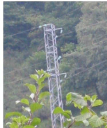
1Q TRESBOLILLO Metálico+amarre+derivación
