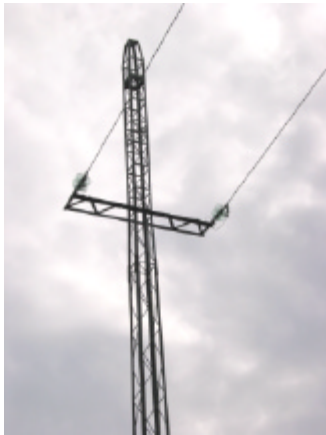
59A MONTAJE 1 AMARRE SUPERIOR Metálico
