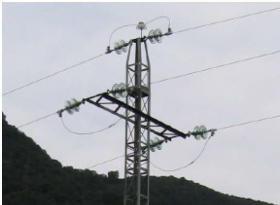
12C MONTAJE 1 AMARRE SUPERIOR Metálico
