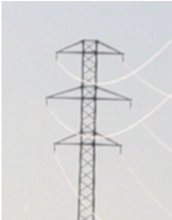
41B DOBLE CIRCUITO Metálico+alineación+derivación
