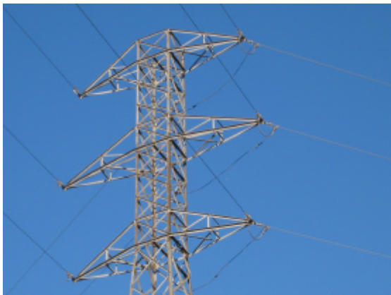
41E DOBLE CIRCUITO Metálico+amarre+derivación
