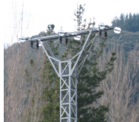
42E MONTAJE 0 AMARRE INFERIOR Metálico+seccionador
