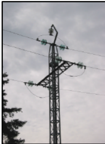
Montaje 1. Amarre inferior con farolillo en puente
