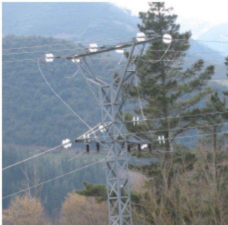
49 MONTAJE 0 AMARRE INFERIOR Metálico+derivación
