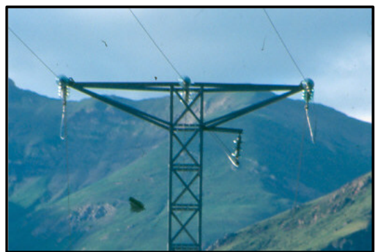
Puente central corregido e instalado por debajo del travesaño
