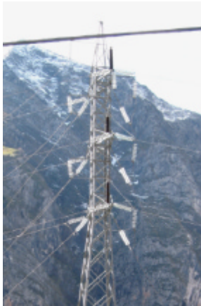
55 DOBLE CIRCUITO Metálico+derivación
