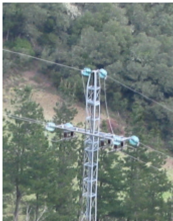
33B MONTAJE 1 AMARRE INFERIOR Metálico+farolillo
