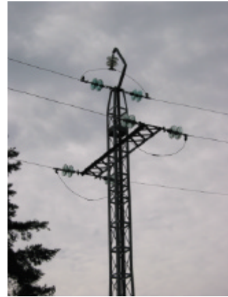
22A MONTAJE 1 AMARRE INFERIOR Metálico+farolillo+derivación
