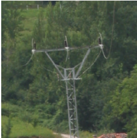
44 MONTAJE 0 AMARRE SUPERIOR Metálico+seccionador+subterráneo
