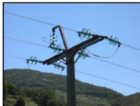
Montaje 0. Amarre inferior con farolillo en puente central
