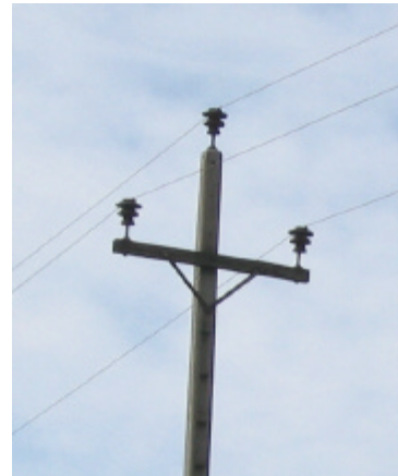
12D MONTAJE 1 AMARRE SUPERIOR Hormigón
