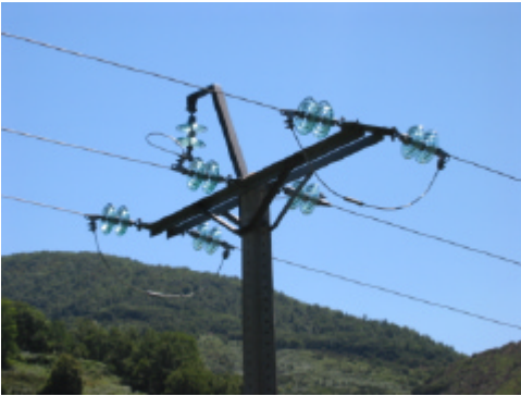
37E MONTAJE 0 AMARRE INFERIOR Hormigón+farolillo
